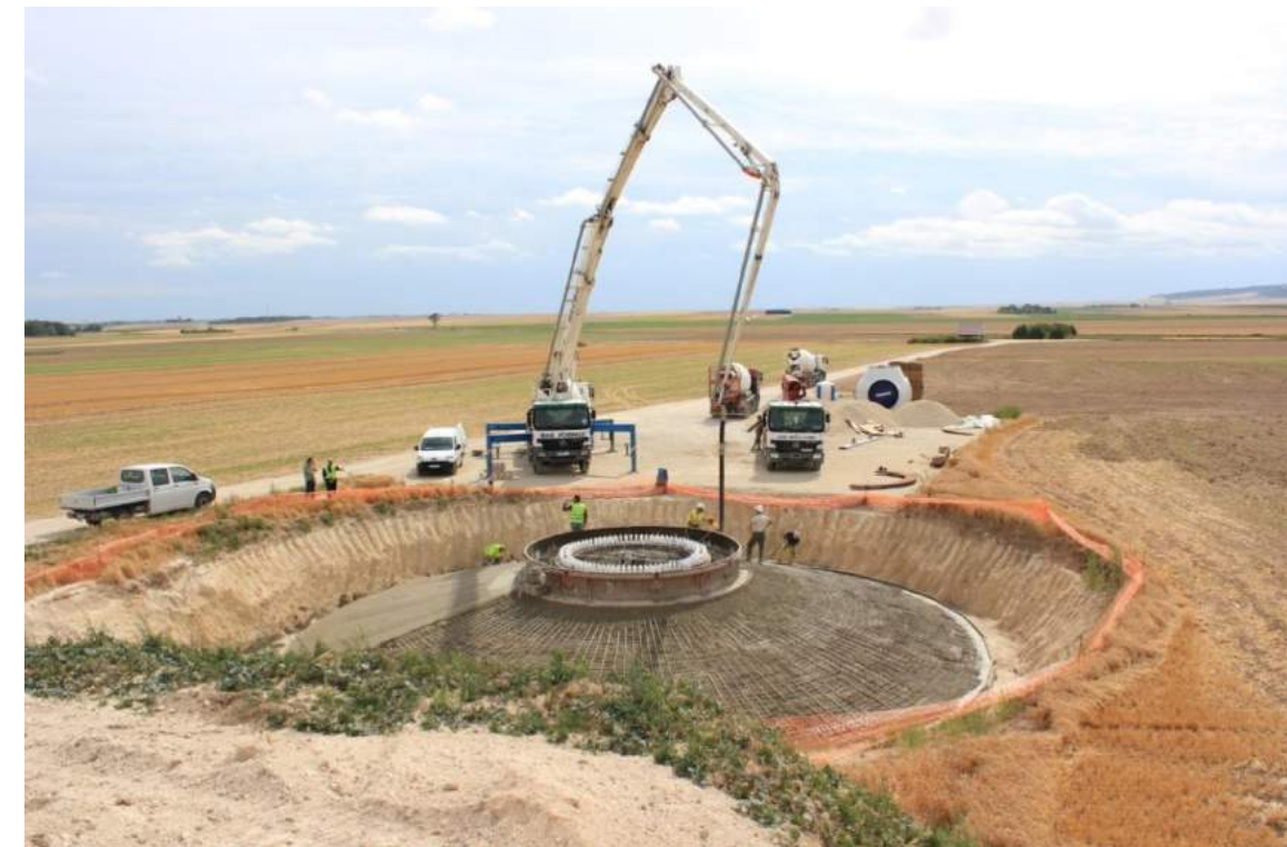
Photographie 5 Construction d'une fondation d'éolienne
