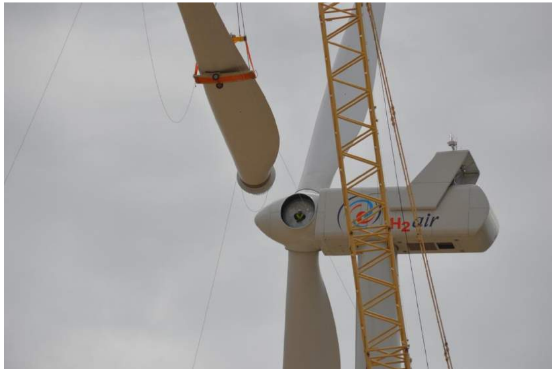
Photographie 4 Assemblage d'une pale
