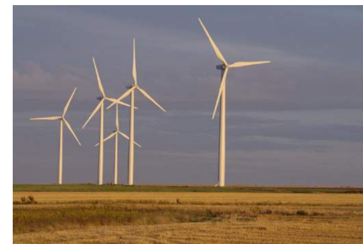
Photographie 3 Parc éolien Seine Rive Gauche
