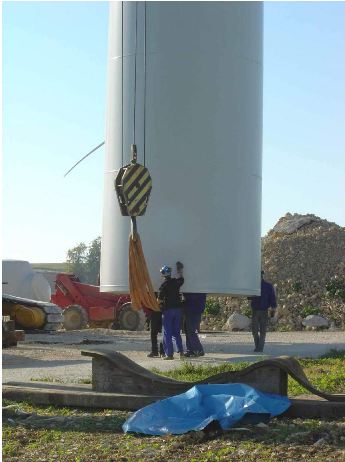
Photographie 9 Levage d'une section de mat
